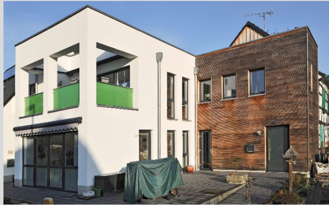
Zweifamilienhausanbau Büscherhöfen 29, Leichlingen Baujahr: 2010-2011
