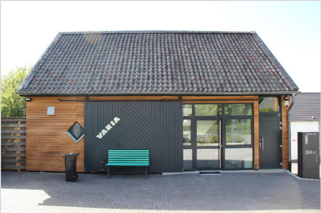
Aus einer alten Scheune entsteht hier, nach dem Ausbau des Erdgeschosses und Neugestaltung der Außenfassade, unser Büro.
