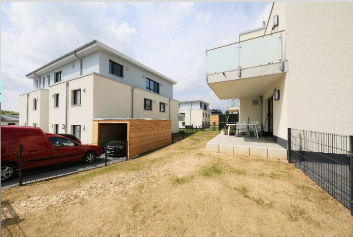
Neubaugebiet Rötzinghofen Vier 5-Familienwohnhäuser Im Hagen 17+19, Am Bornheimer Bach 2+4 Burscheid Baujahr: 2022
